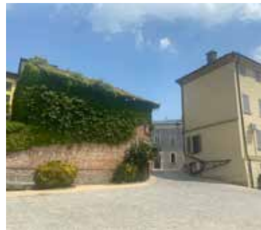
CASTAGNOLE DELLE LANZE (AT) REALIZZAZIONE NUOVO BELVEDERE
