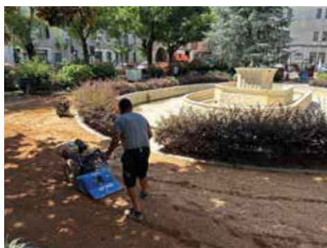
2. | Miscelazione terreno trattato con soluzione GREEN WAYS
