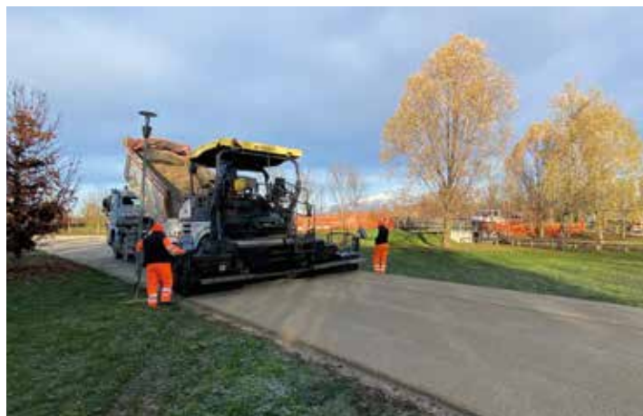
2. | Posa a freddo del terreno trattato con soluzione Green Ways
