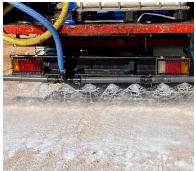
6) Applicazione finale antipolvere diluito in acqua
