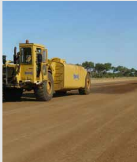
3) Compattazione e idratazione del terreno trattato con GREEN STAB
