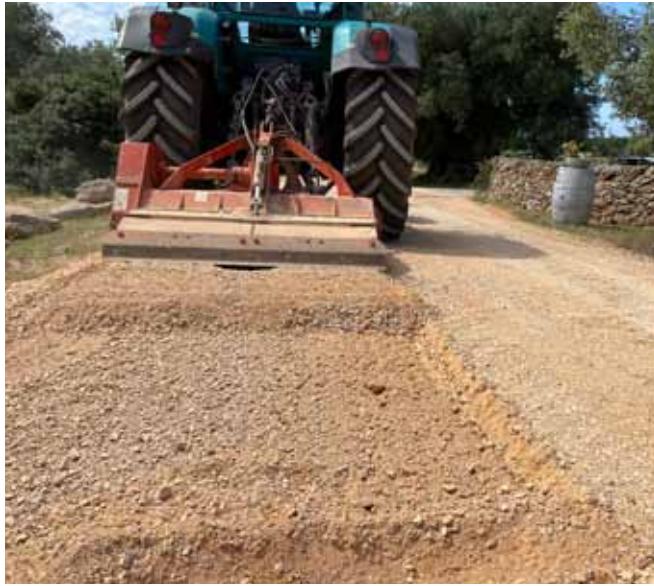
1) Fresatura terreno presente in situ
