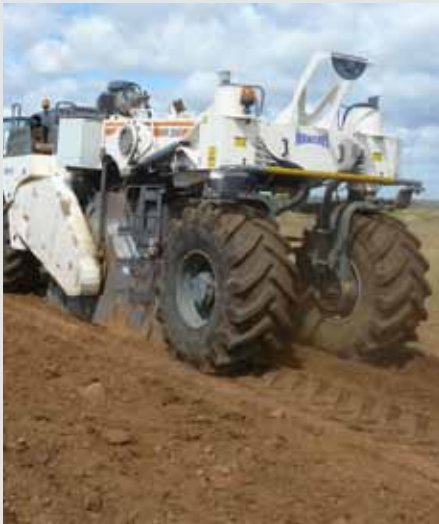
1) Applicazione GREEN STAB diluito in acqua per stabilizzazione terreno naturale
