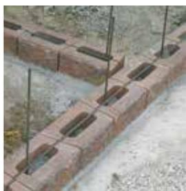
armatura verticale e orizzontale con tondino da Ø5 mm.
