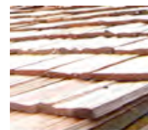
Tetto in scandola
